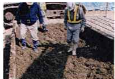
改良を終えた状態。ポンテラン土と名付けている
