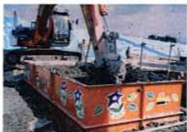
油圧ショベルにアタッチメントを付けて汚泥をかき混ぜる
