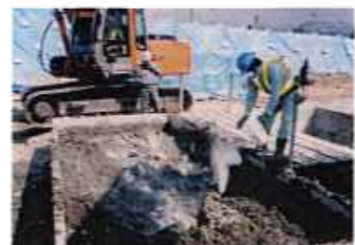
次に、汚泥の表層に吸水性の高分子系改良剤を均等に振りかける
